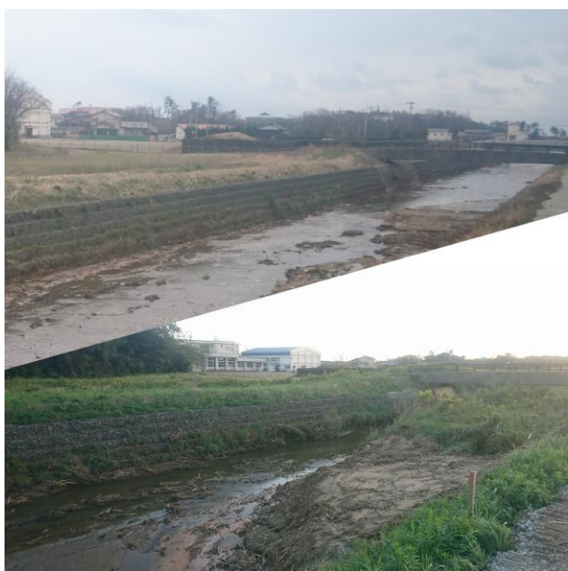
相見川の工事箇所
