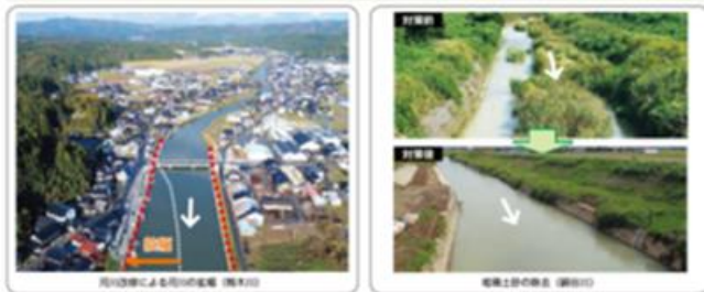
河川の土砂除去工事の様子（県土木部資料）
