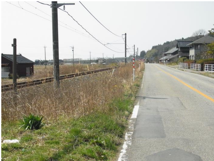
県道七尾羽咋線の鹿島路町周辺
